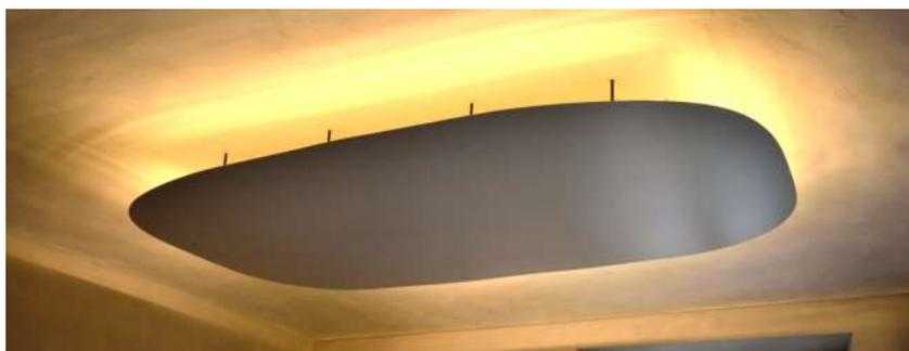
**SOLE** è un sistema di Riscaldamento e Raffrescamento a soffitto per Irraggiamento a bassa Temperatura.
